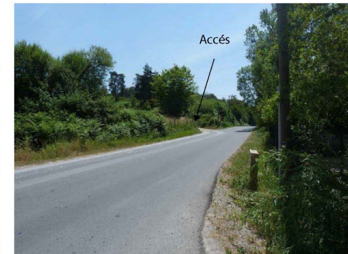
7 - Vue depuis le Nord de la carrière. Au fond à gauche l'accès
