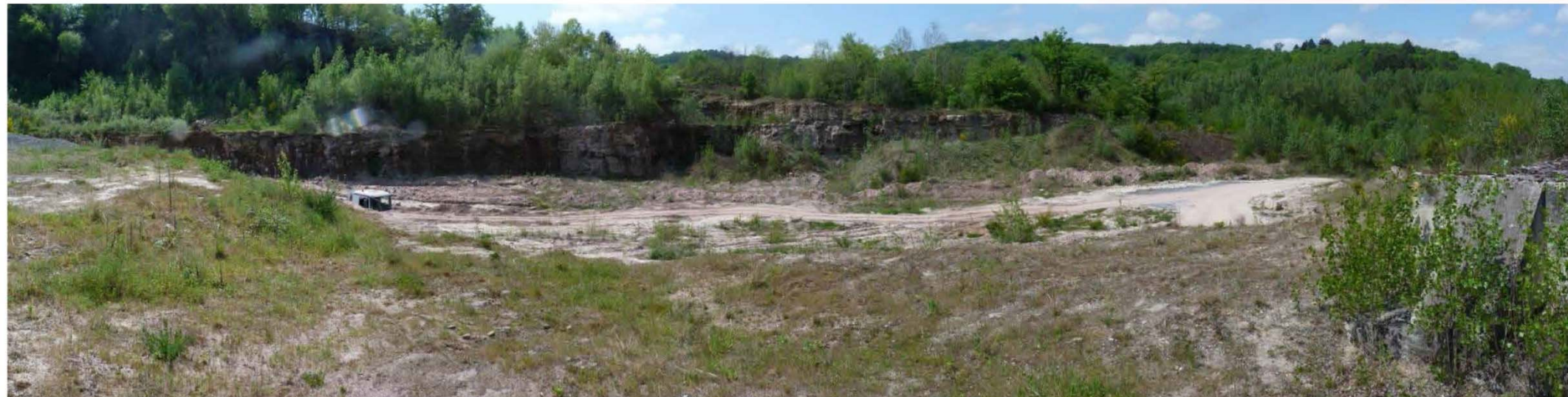
3 - Vue sur la partie Ouest de la carrière - piste d'accès à la zone d'exploitation en cours
